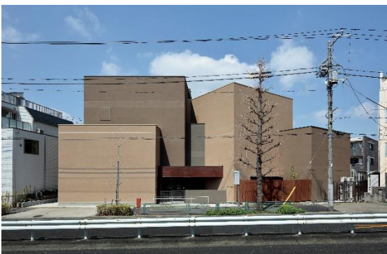
建物正面【目黒通りから】
