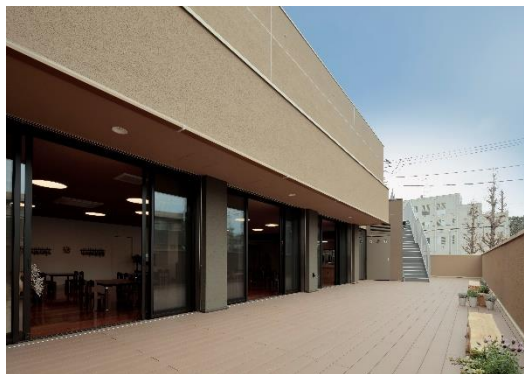
2階 ランチルーム前テラス
